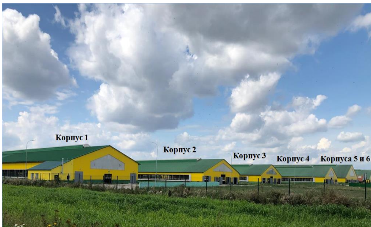
Рисунок 2— Схема размещения половозрастных групп стада голштинских коров на молочном комплексе. Усл. Обозначения: корпус 1 – молодняк от рождения до 6 месяцев; корпус 2 –молодняк от рождения от 6мес. до 12 мес.; корпус 3 – телки случного возраста и нетели; корпус 4 – сухостойные коровы, родильное госпитальное; корпус 5 – новотельные коровы и коровы на раздое; корпус 6 – дойные коровы.
