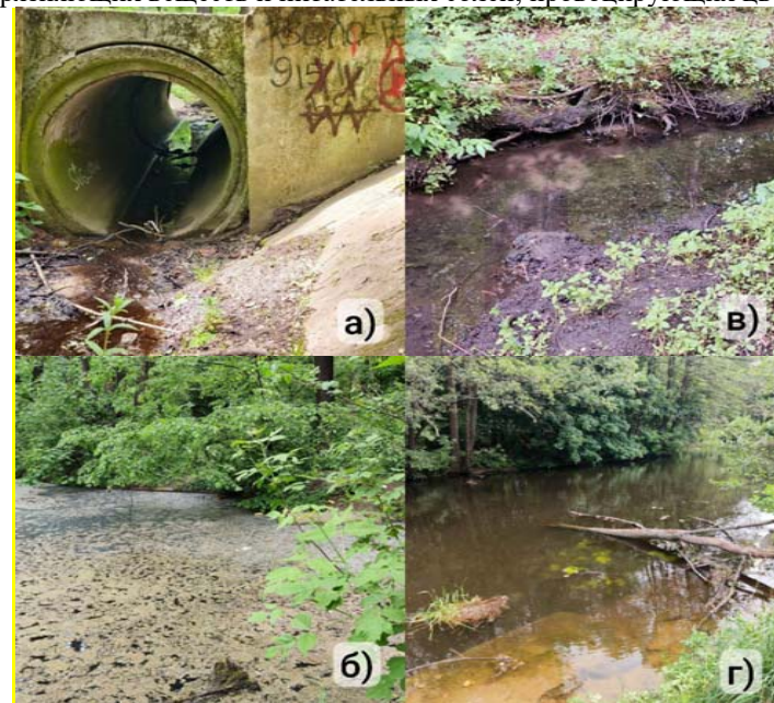
а) Неудовлетворительное состояние коллектора реки Жабенка. б) Цветение реки и высокая степень зарастания береговой линии. в) Эрозия береговой линии. г) Падение крупных деревьев в русло реки и деградация берегоукрепительных сооружений.
