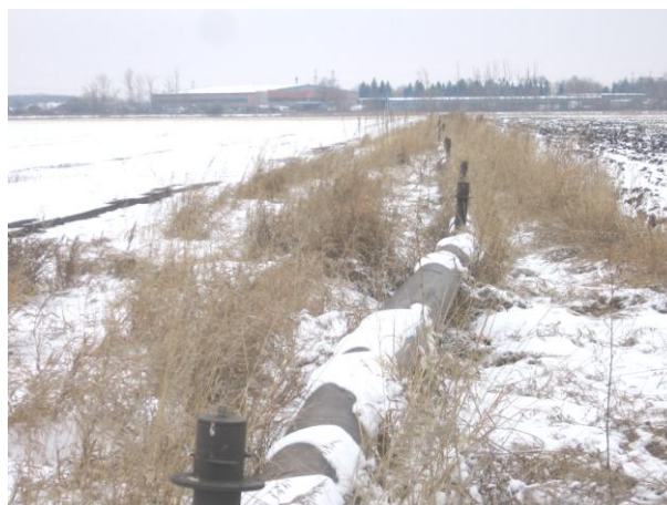
Рисунок 5 – Полевой трубопровод с гидрантами для подключения ДКШ-64 «Волжанка»
