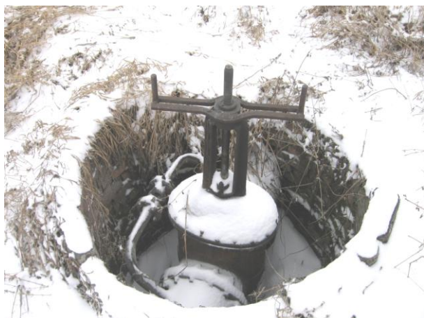
Рисунок 4 – Смотровой колодец на оросительной сети
